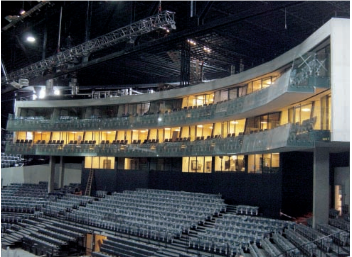
Im Halleninnern konnte das Dachtragwerk aus 92 m langen und 11 m hohen Fachwerkträgern erhalten werden. Neu in die Südcurve eingebaut wurde ein geschwungener Betonkörper mit 20 Logen. (Foto G. Hoch)
