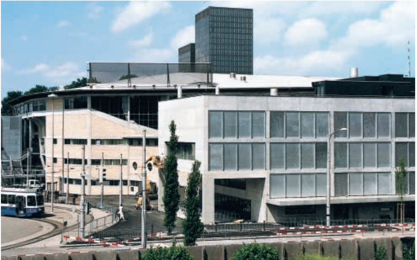
Das Hallenstadion in Zürich konnte durch eine Sanierung in seiner Substanz erhalten und für eine multifunktionale Nutzung eingerichtet werden. Südseitig wurde ein Vorbau als Conference Center angegliedert. (Fotos Curt Mayer)
