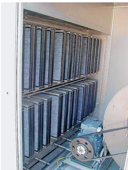
Bild 2: Geruchsneutralisation mit Aktivkohlefiltern
