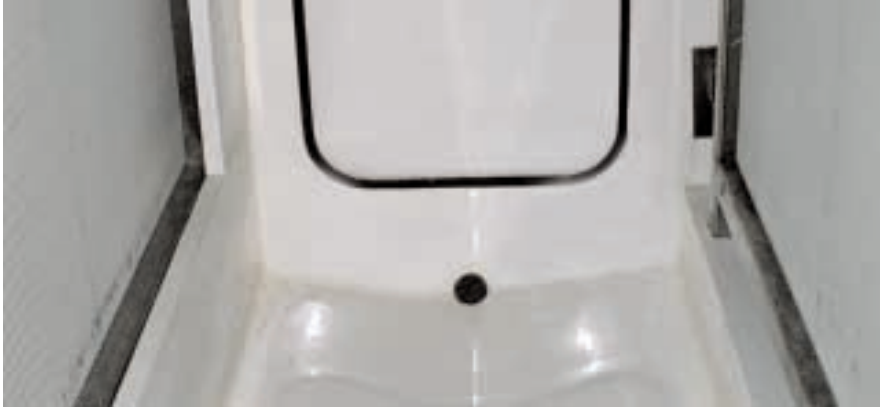
Revisionsteil zwischen zwei Wärmetauschern. Zur Vermeidung von stehendem Wasser gibt es an diesen Tauschern keine horizontalen Flächen.
