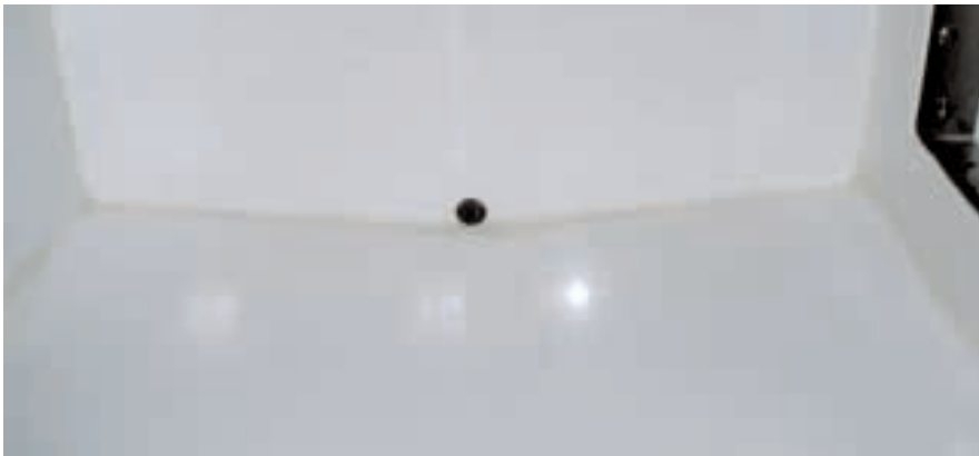
Wanne mit allseitigem Gefälle, Radius in den Übergängen und dem Ablauf revisionsseitig.
