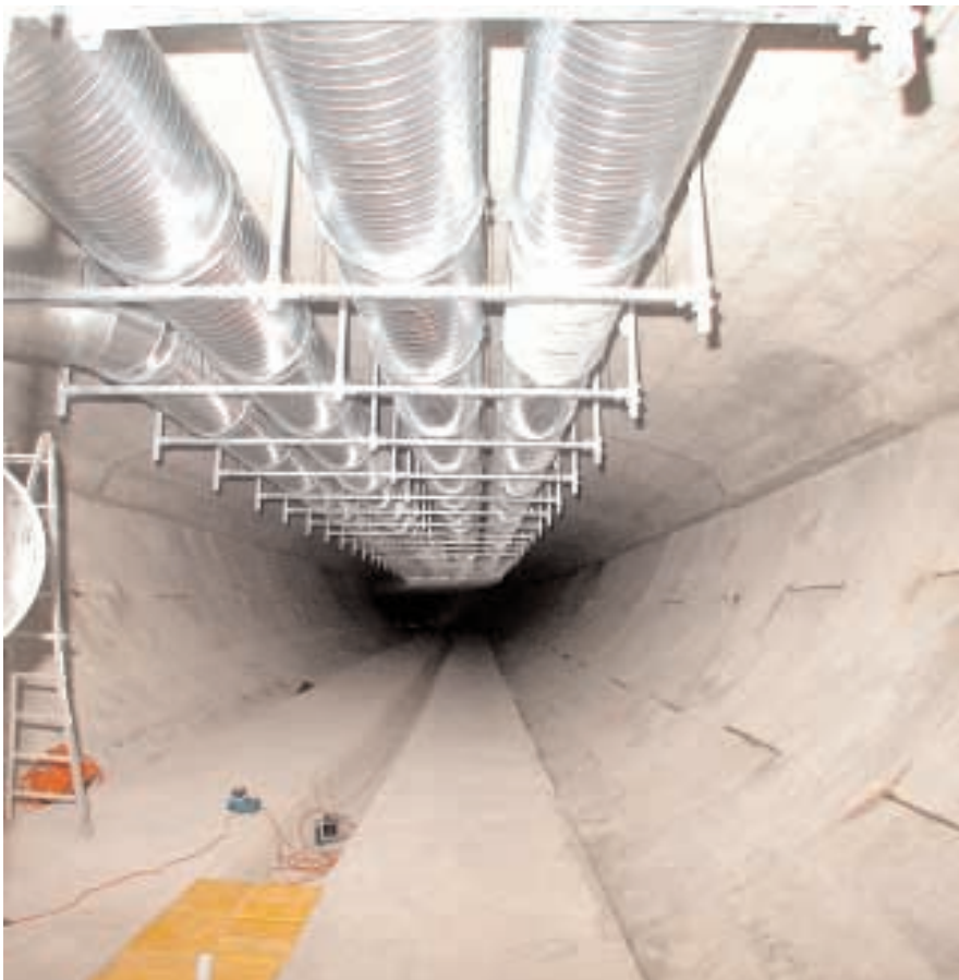
Rohrmontage (Zuluft Querschläge) in einem der Frischluftschächte (Tunnel) über der Autobahn.
