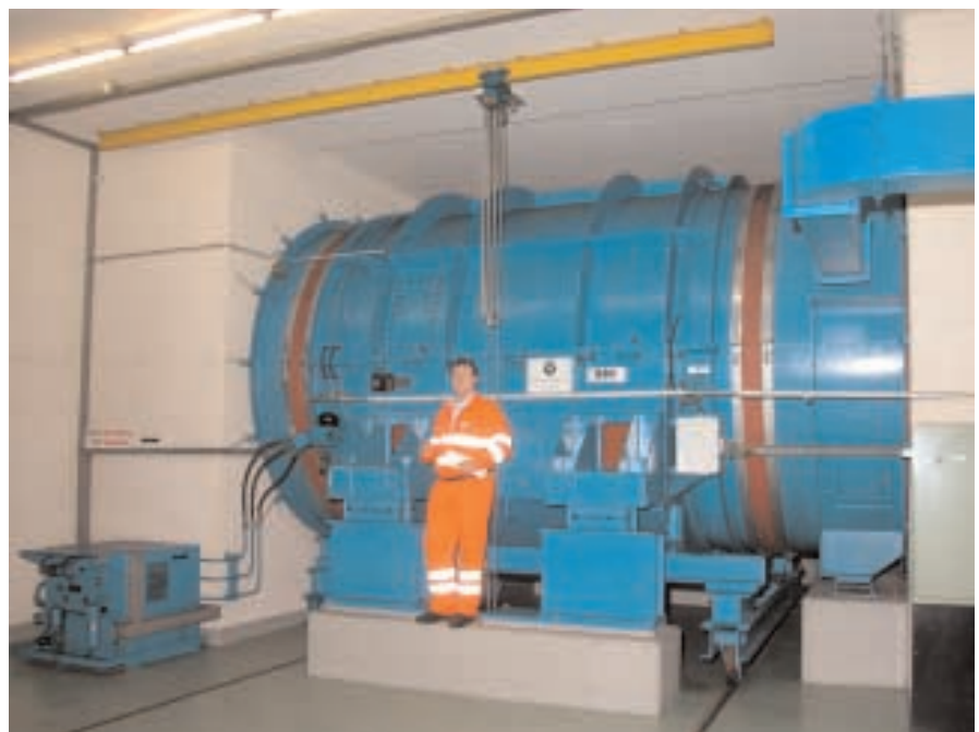
Ehemals von BBC gelieferte Tunnelventilatoren. Die Anordnung ist über der Autobahn. Bei einem Austausch werden die Ventilatoren durch die Tunneldecke auf einen Anhänger gebracht.
